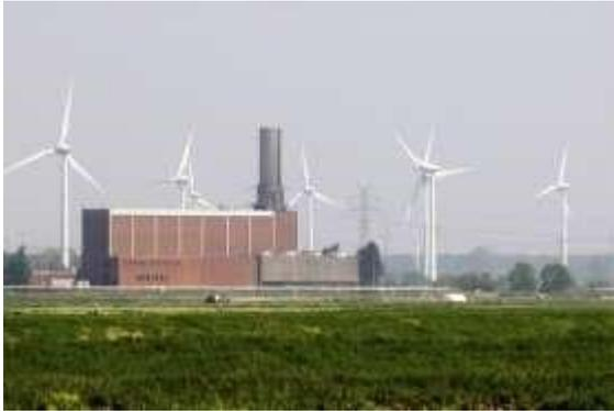
Auf einem Salzstock in Huntorf wurde 1978 das weltweit erste Luftspeicher-Gasturbinen-Kraftwerk in Betrieb genommen. Der Spitzenlastblock wird voll automatisiert ohne örtliches Personal vom Kohlekraftwerk Wilhelmshaven ferngesteuert und überwacht.
